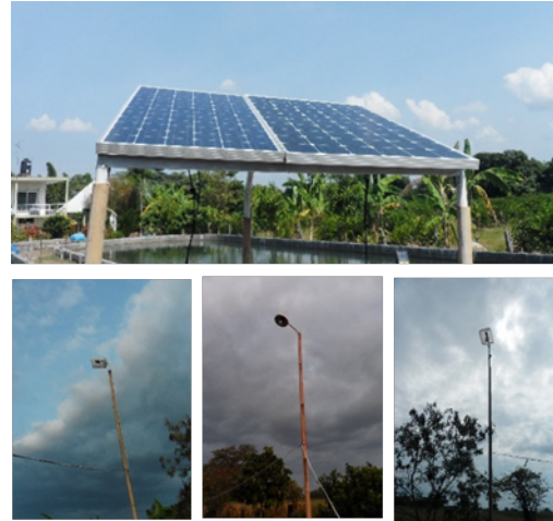
Fig. 5. Instalación del sistema
