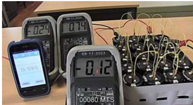
Ilustración 15. Práctica de carga y descarga del banco con ultracapacitores.
