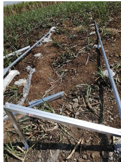
imagen 14 armado de estructura
