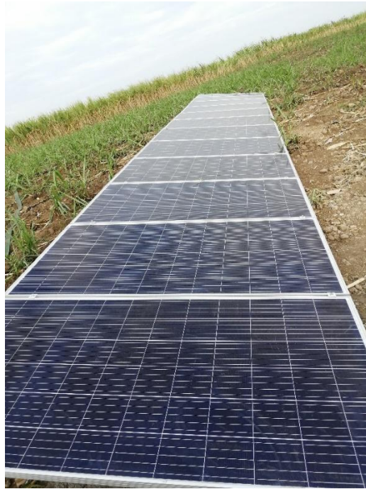
imagen 16 alineación de paneles
