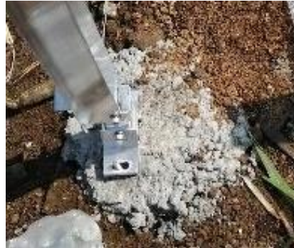
imagen 12 base de concreto
