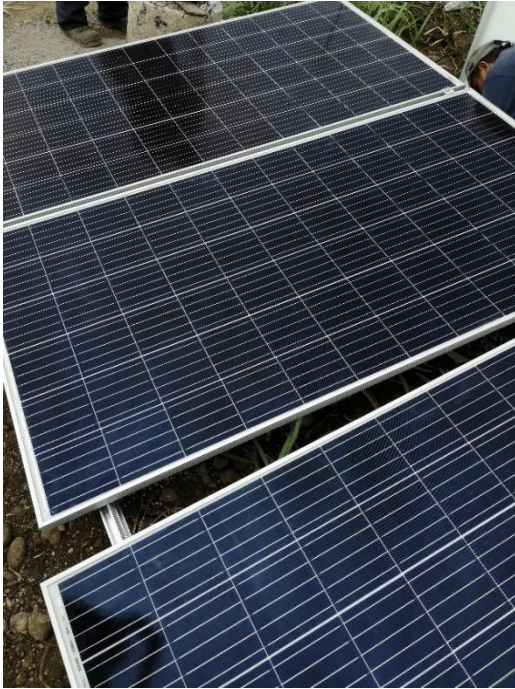
imagen 15 montaje de paneles
