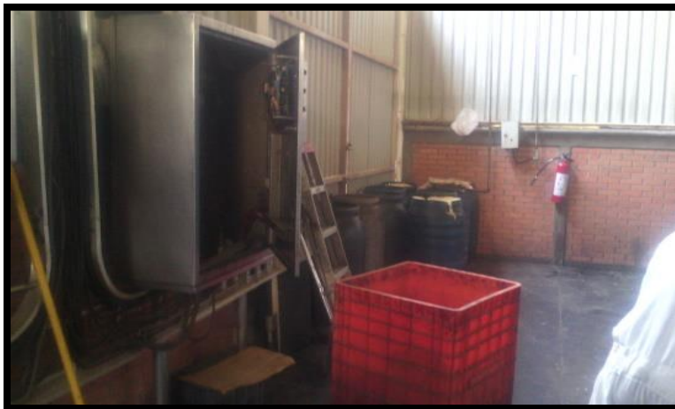
Fig.19 Inspección en el Área de calderas
