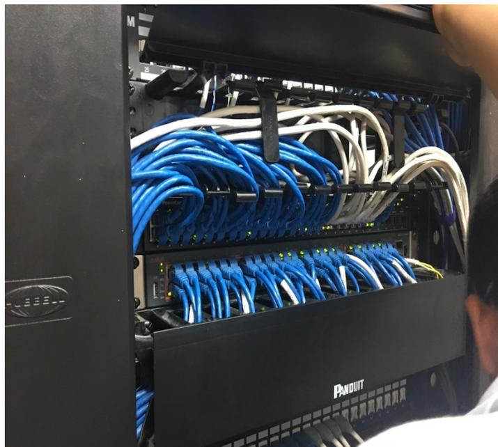
Al momento de empezar la implementación de este equipo, se comenzó con la retirada de todos el cableado por parte del switch siguiéndole de el retiro de este equipo para poder establecer el nuevo dispositivo y todo marchaba como lo esperado.
