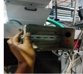
Imagen 12 Atornillado de caja de control
