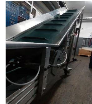
Imagen 11 Cableado de sensor
