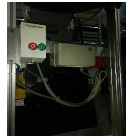
Imagen 19 Colocación de tapa
