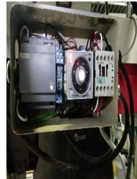
Imagen 15 Instalación del control
