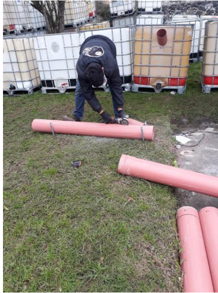
Figura 3.5 cortando el tubo
