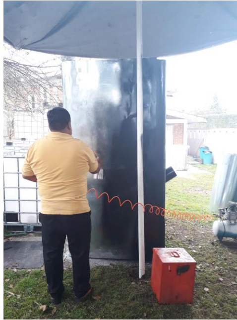
Figura 3.15 pintando el biodigestor
