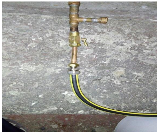
Figura 1.20 Instalación del equipo
