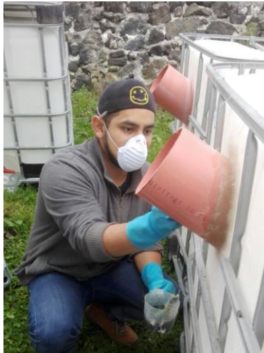
Figura 1.7 Colocando fibra de vidrio
