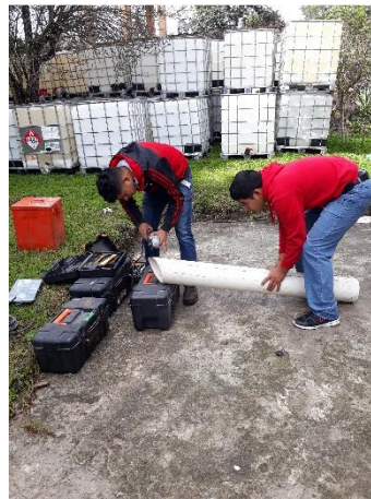
Figura 3.4 cortando el tubo
