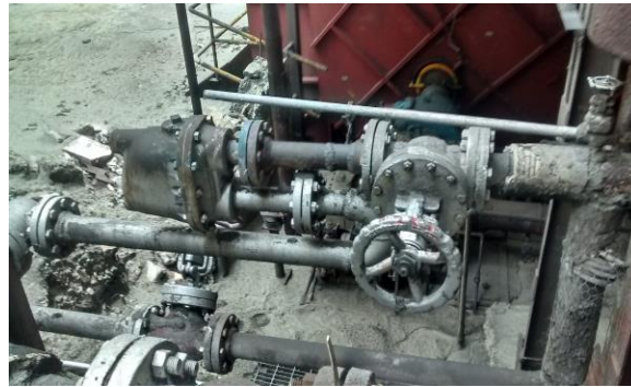
Ilustración 33 trampa de condensados con dirección a turbos.
