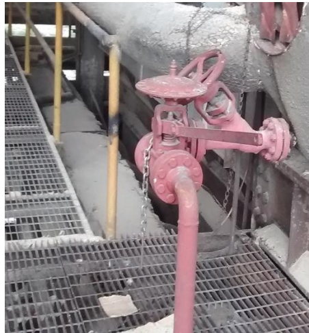
Ilustración 10 Purga de una caldera, Siempre será de color rojo.
