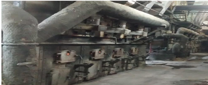
Ilustración 6 Compuertas de los hornos de las calderas 11 y 12, Estos hornos son de parrillas volcantes.
