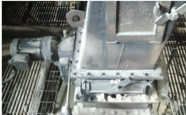
Ilustración 15 Alimentador de bagazo de la caldera N°14
