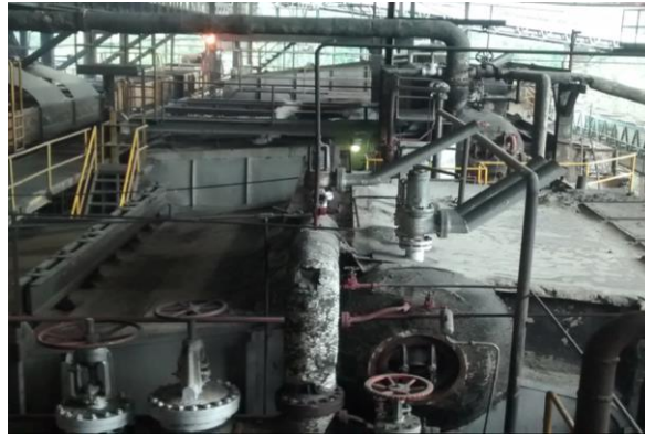
Ilustración 4 Domo de vapor de una caldera.
