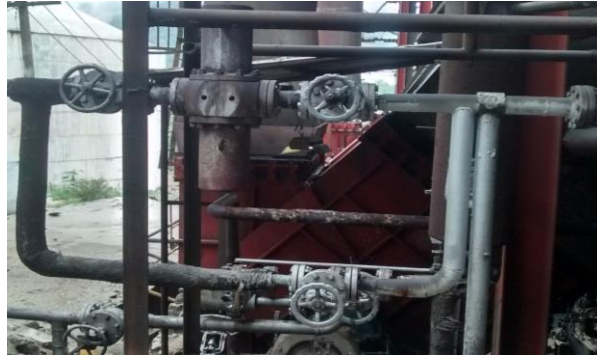
Ilustración 32 trampa de vapor con dirección a turbos.
