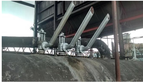
Ilustración 28 Válvula de seguridad, se puede calibrar para que a una presión determinada esta pueda abrirse y liberar el vapor a la atmosfera.
