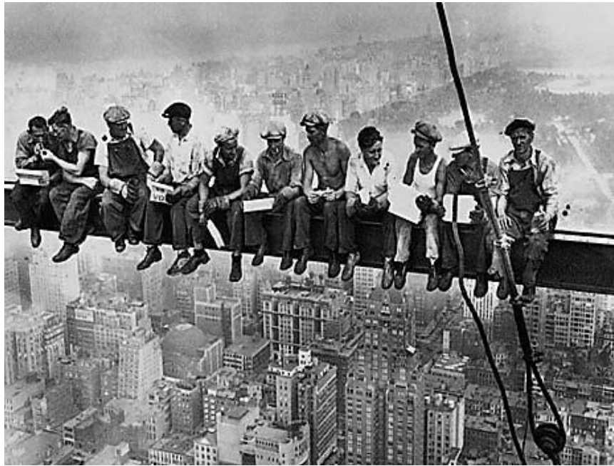
Fig. 1 Trabajadores de la construcción en New York, a principios del Siglo XX, sin protección y/o EPP
