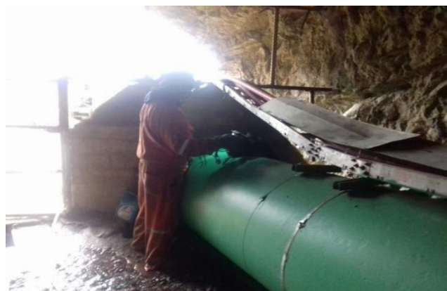
Ilustración 10 Evaluación de la tubería.
