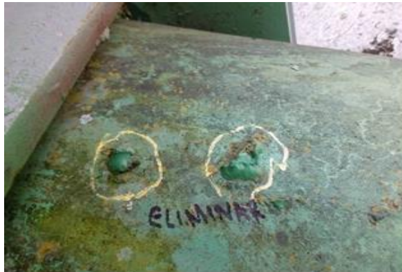
Ilustración 1 Restos de soldadura.
