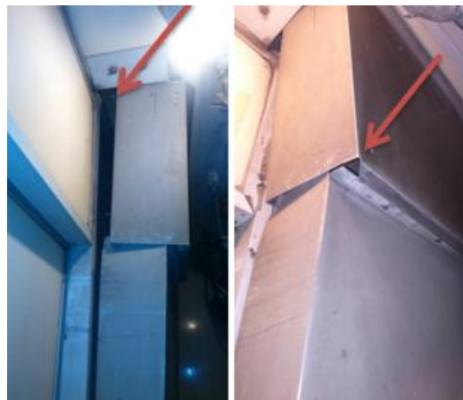
Ilustración 35 Dámper fuera de posición
