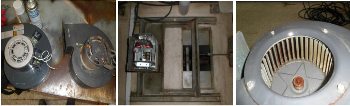
Ilustración 50. Reemplazo de motores, limpieza de aspas y gabinete
