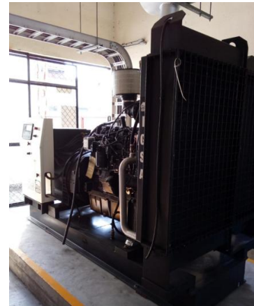
Ilustración 1 Planta de emergencia
