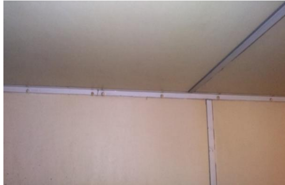
Ilustración 45 Pared y techo limpio
