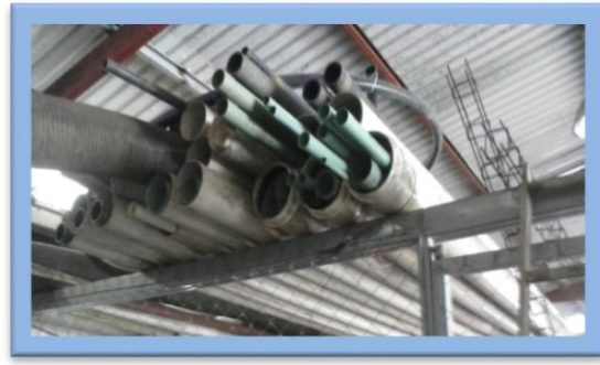
Área de tubería 2- Antes
