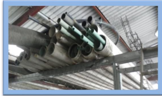
Área de tubería 2- Antes
