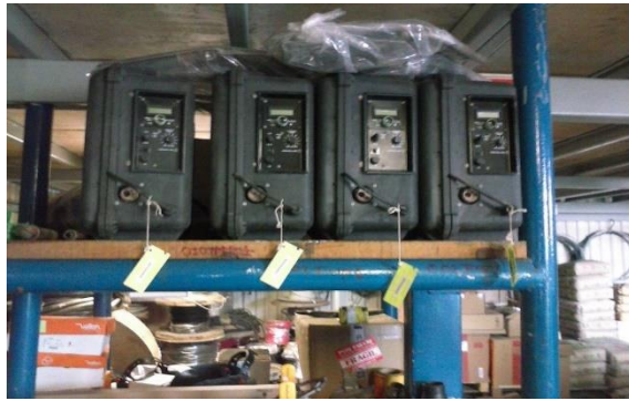
Área de motores 4 - Después
