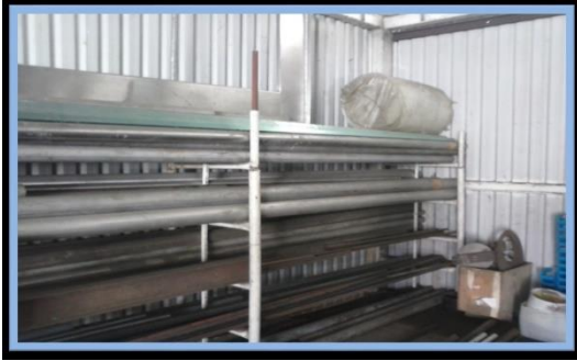
Área de tubería 1 – Después
