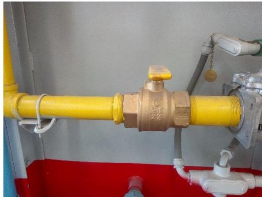
*Ilustración 8 válvula de flujo de gas natural.*
