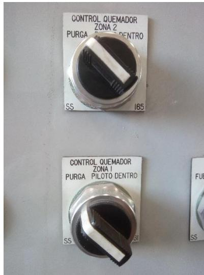
*Ilustración 10 selectores para control de quemadores zona 1 y 2.*
