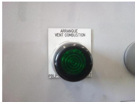
*Ilustración 9 botón para encender ventilador de combustión.*
