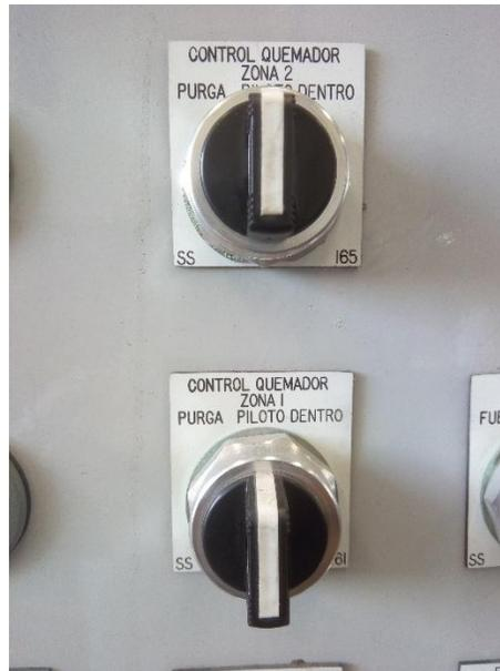
*Ilustración 16 selectores de control de quemadores.*
