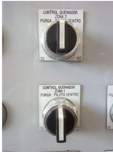
*Ilustración 20 selectores de control de quemadores.*
