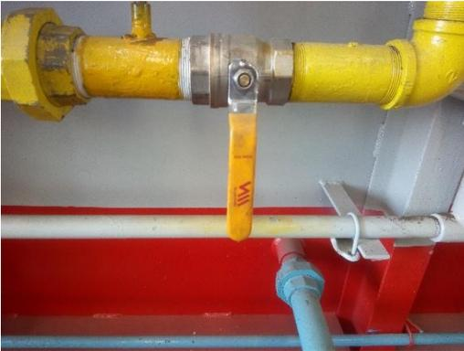
*Ilustración 7 válvula de gas natural principal.*
