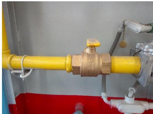
*Ilustración 34 válvula de flujo de gas natural.*
