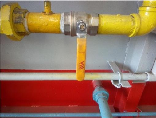
*Ilustración 33 válvula de gas natural principal.*
