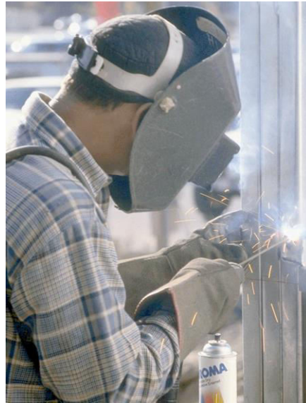
Ilustración 10. Aplicación de soldadura
