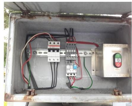
**Imagen. 3.6.** Instalación de botones de encendido y apagado.
