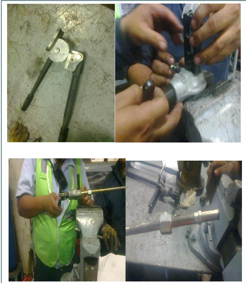
La primera fase del proyecto a realizar fue de instalar la soporteria para la red de tubing los cuales serían instalados en ciertos puntos para este sistema hasta llegar a las cadenas de la maquina dezcamadora de tochos,
