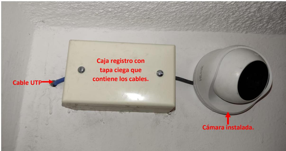
*Figura 83 Instalación finalizada cámara 1 – MATRIZ*
