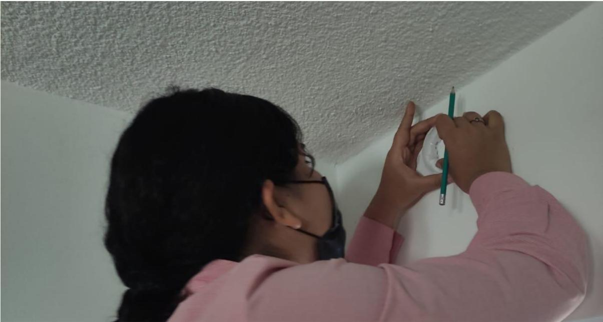
Figura 79 Realizar marcas para perforar pared cámara 1 – MATRIZ
