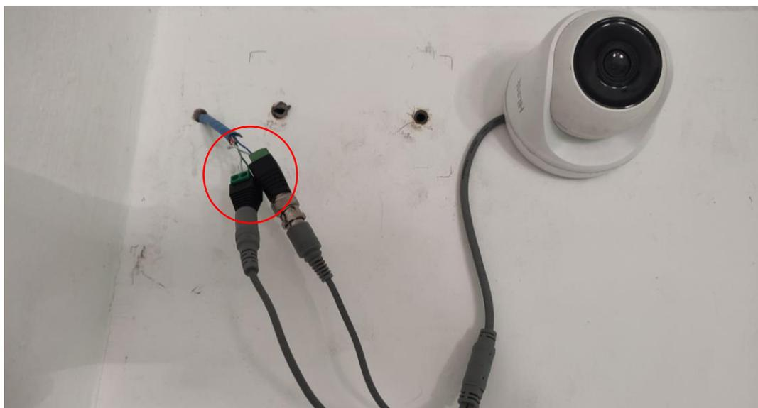
Figura 82 Instalación de cámara analógica 1 – MATRIZ
