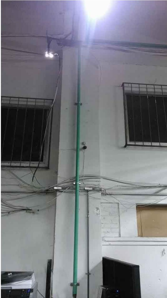
Para que la base de la instalación fuera sólida se tuvo que pasar por la estructura metálica del edificio la cual está a una altura de aproximadamente 7 metros de altura en la siguiente imagen se ve por donde pasan los tubos PVC los cuales protegen los cables de red.
