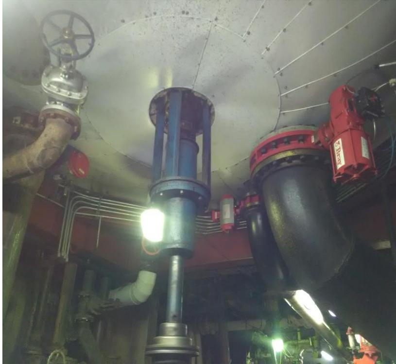
Fig. 3.7 Descarga de tacho controlada con válvula semiautomática.
