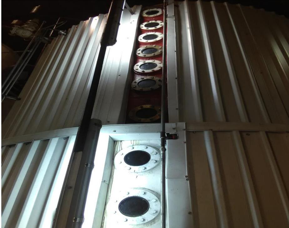
Fig 3.3 Mirillas por las cuales se observa el nivel y la cocción de la meladura.
