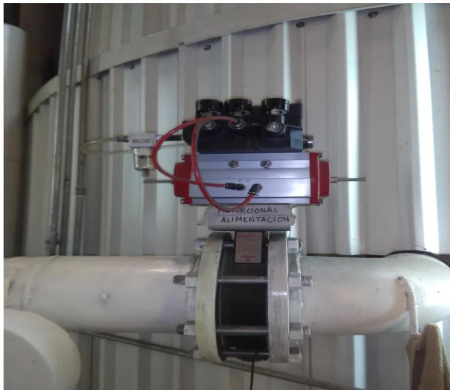
Fig. 3.4 Entrada principal de meladura controlada por una válvula de paso semiautomática.
