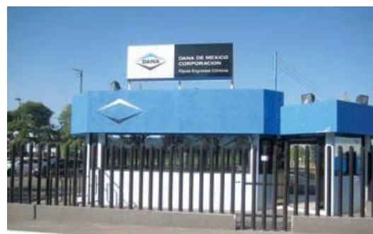
Fig. 5 Instalaciones de DANA ENCO en Querétaro, Qro.
