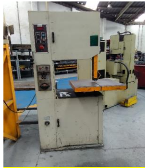
Equipos sin etiquetas de identificación.
