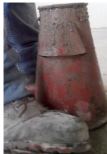
Imagen 9. Retirando el molde del concreto.
