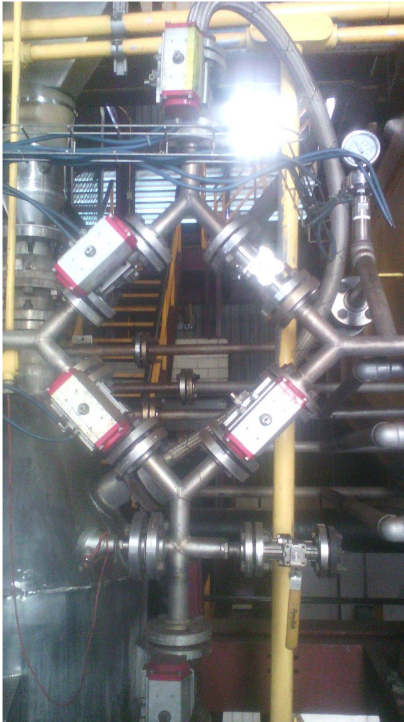
Imagen 3.3 rombo de válvulas de dirección de flujo
