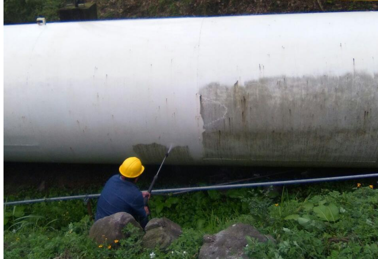
Figura 22. Limpieza de tuberías (Fuente: PROENERMEX S.A. de C.V.)
