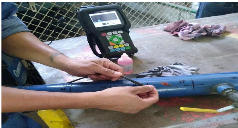
Figura 31. Inspección de tubería (Fuente: PROENERMEX S.A. de C.V.)
