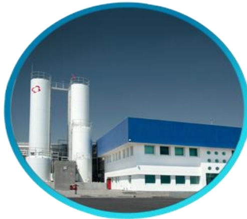
Figura 10. Complejo industrial laguna.
