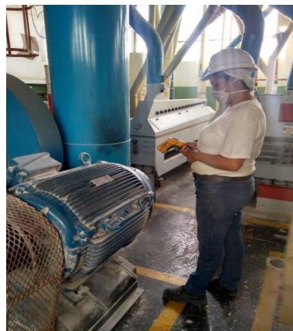
Imagen 12 Medición de temperatura a M4NGE
