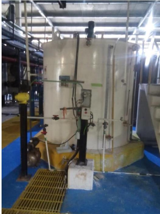
*Ilustración 12. Tanque para dosificaciones de alcalinidad.*
