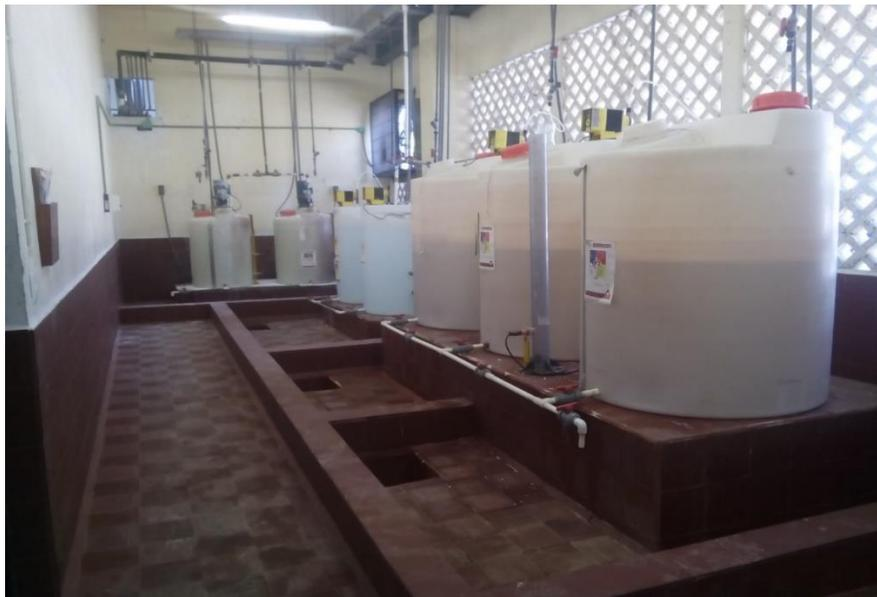
*Ilustración 22. Área de químicos, cloro, antiescalante y metabisulfito.*
