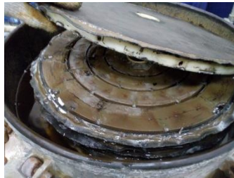
Ilustración 25 Filtro lleno de grasas.
