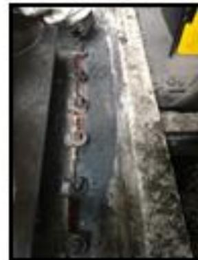
Ilustración 36 En esta imagen se puede apreciar la colocación de cordón cerámico nuevo a su tubo radial del horno UBG - DCM.
