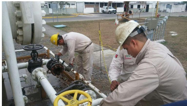
*Ilustración 30: Operarios de primera y especialistas desinstalando válvulas del separador bifásico,*
