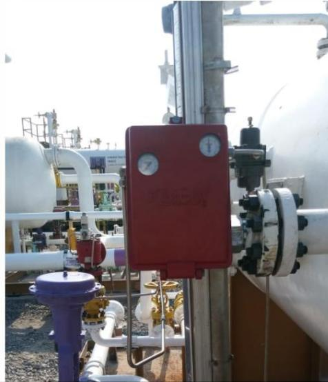
*Ilustración 48: Regulador de baja y caja de control kimray instalada en posición de nivel*
