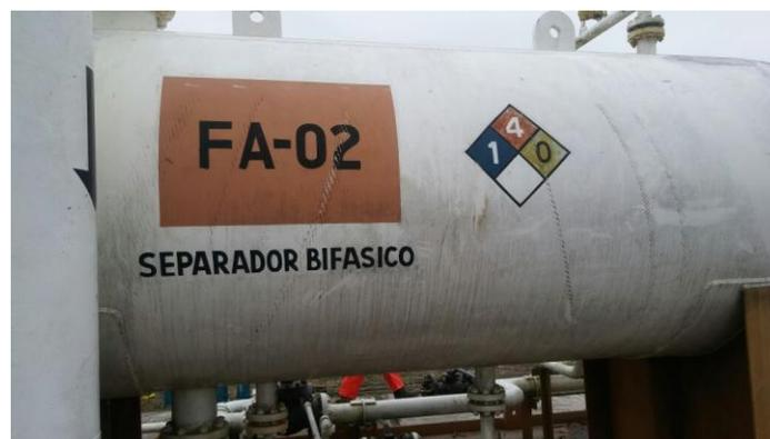
Ilustración 21: Vista se separador bifásico FA-02
