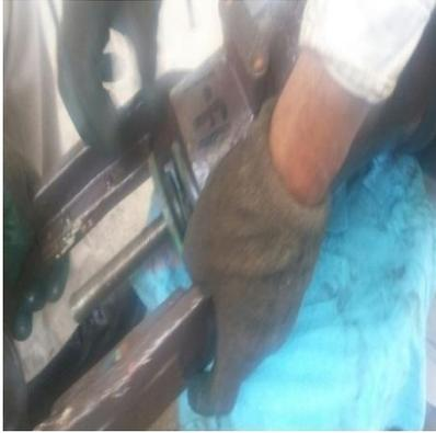
La parte del bonete se desinstala para poder retirar el actuador que es la parte más importante de la válvula y poder lubricarlo, así realizara función de cerrar o dar apertura a la variable que se está controlando
