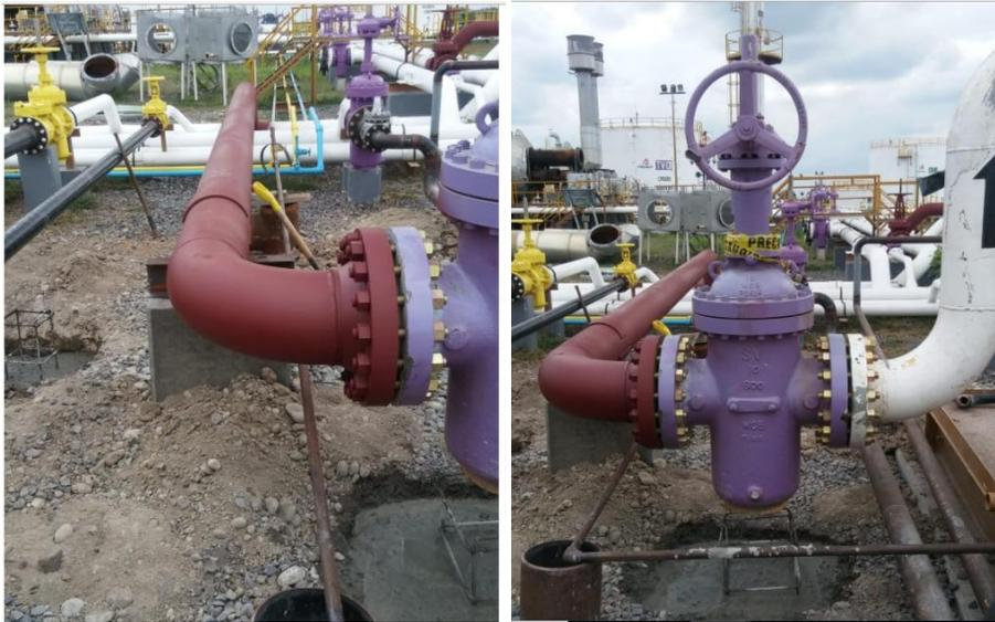
*Ilustración 34: Válvula 10"600# RTJ la cual controla el acceso o cierra de entrada hacia el dispositivo.*
