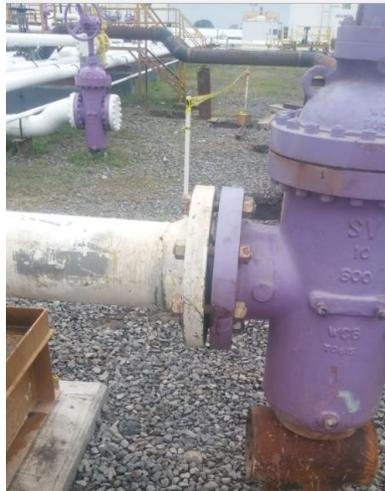
*Ilustración 35: Válvula 10"600# entrada de Gas*
