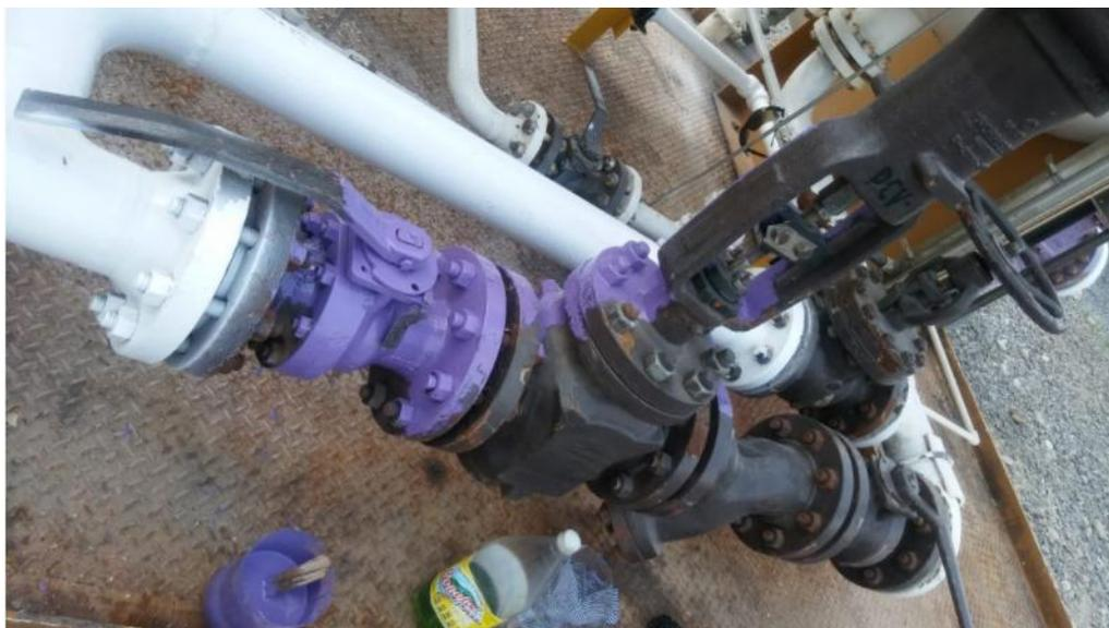
*Ilustración 44: Válvulas manipuladoras de Crudo.*
