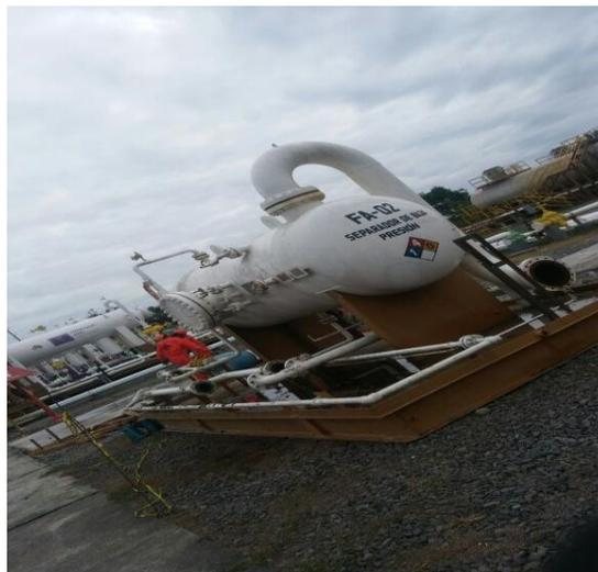
*Ilustración 32: Separador Bifásico FA-02*
