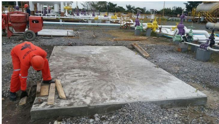
*Ilustración 27: Cimientos terminado de separador Bifásico.*
