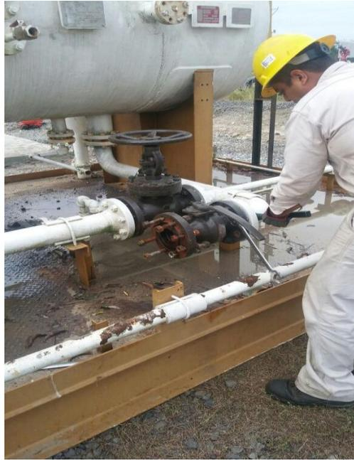
*Ilustración 29: Operario de primera retirando válvula macho con llave de golpe*
