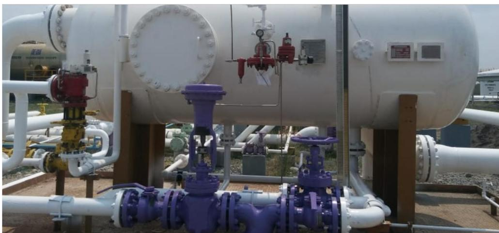
*Ilustración 45: Línea de crudo en el separador*
