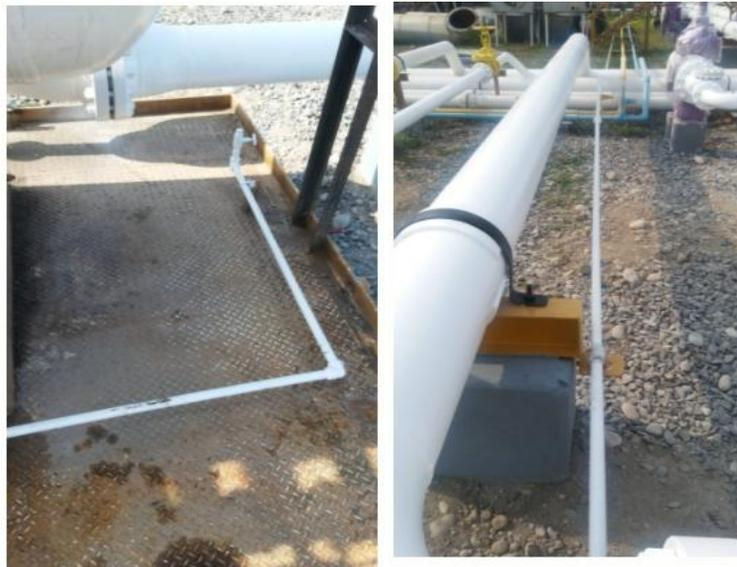
*Ilustración 41: Desfogue de gas suministro y entrada a los instrumentos*
