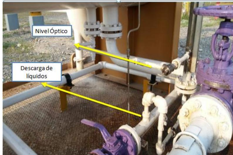
*Ilustración 42: Conexiones de descarga del nivel óptico*
