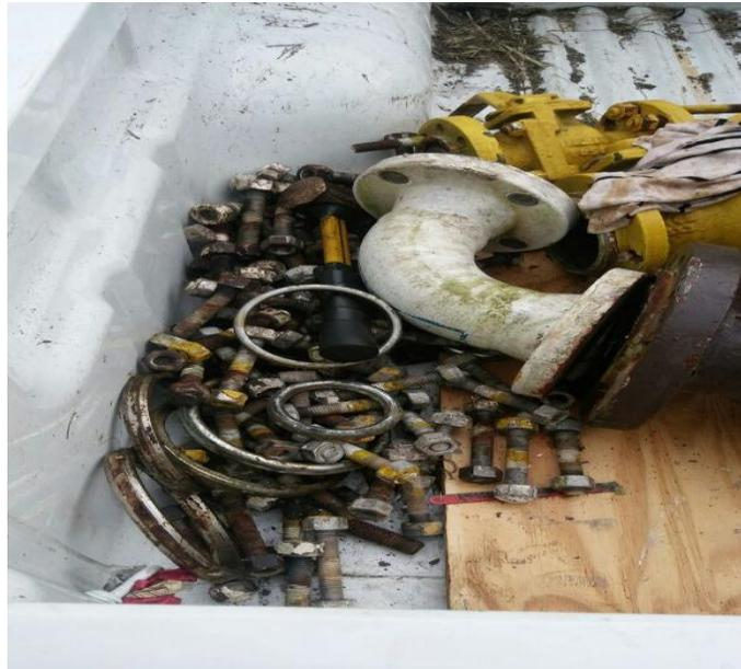
*Ilustración 33: Espárragos, anillos y válvulas desmontadas*
