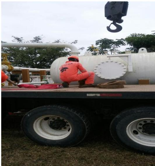
*Ilustración 28: Traslado del recipiente por medio de brazo HIAB*
