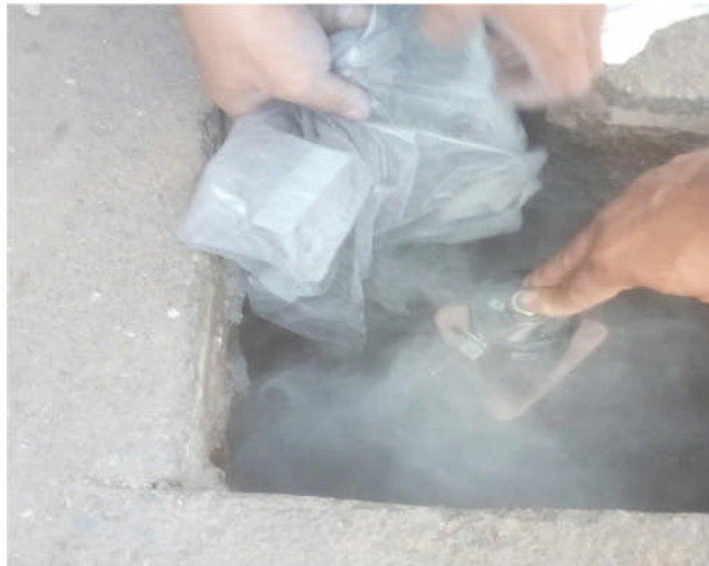
Fig. 3.8 Aplicación de compuesto H20MH
