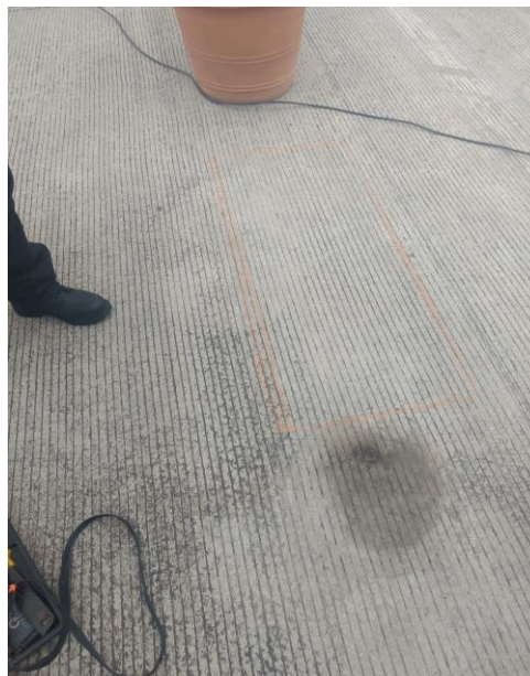
Ilustración 4 Línea de corte para Lazo Magnético
