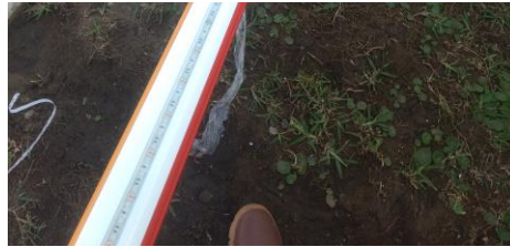
Ilustración 17 Instalación de LEDS a el brazo de la barrera
