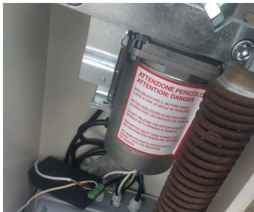
Ilustración 16 Adaptación a la barrera el cableado de la antena RFID
