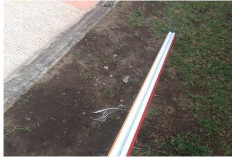
Ilustración 17 Instalación de LEDS a el brazo de la barrera
