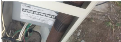
Ilustración 16 Adaptación a la barrera el cableado de la antena RFID
