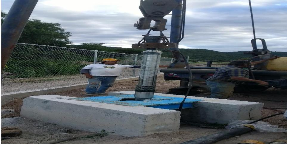
Fig. 9 ensamblé de la bomba para el sistema del agua potable
