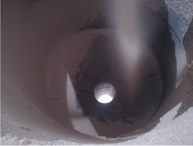
Imagen 4.6.- Esta fotografía fue tomada durante la hechura de la tolva inferior, la cual es de forma cónica.
