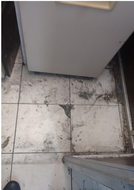
Figura 6.3 - Departamento de fábrica (antes)
