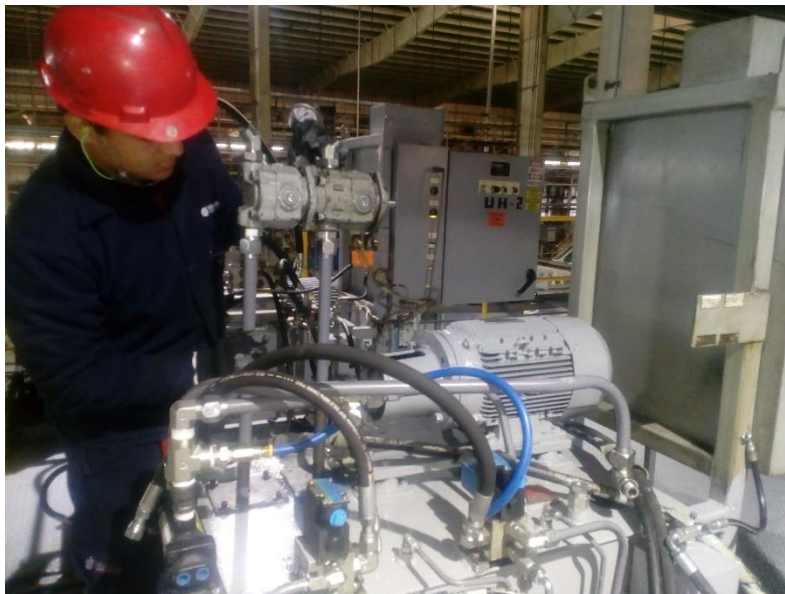
3.5 Conexión de mangueras hidráulicas y dispositivos de control
