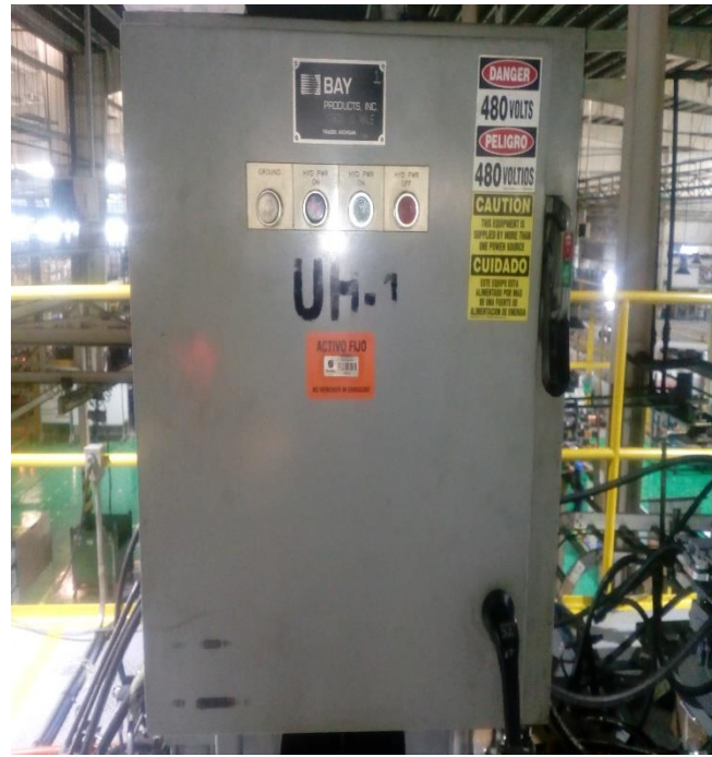
3.6 Tablero de control para unidad hidráulica de contingencia
