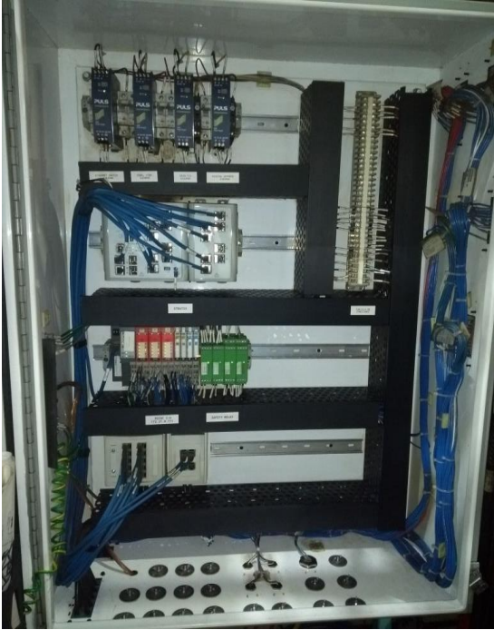
3.6 Tablero de control para unidad hidráulica de contingencia
