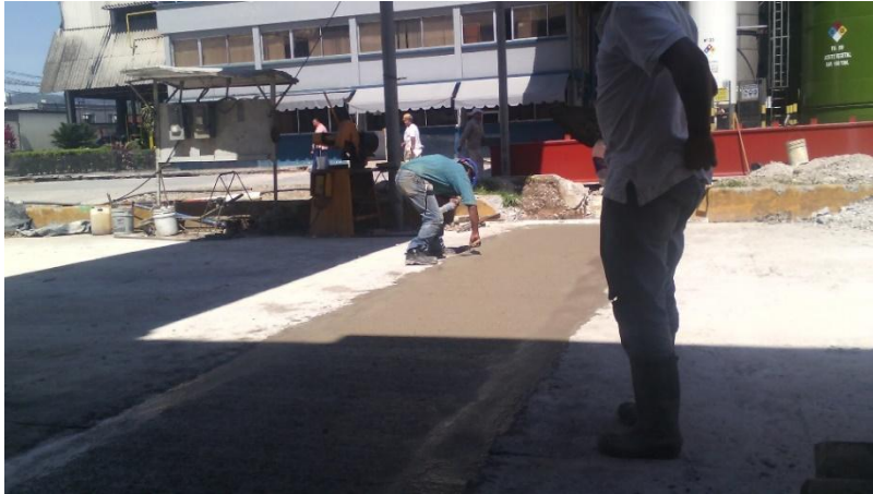
Figura 3.1.4 Cimentación terminada y nivel de piso terminado.
