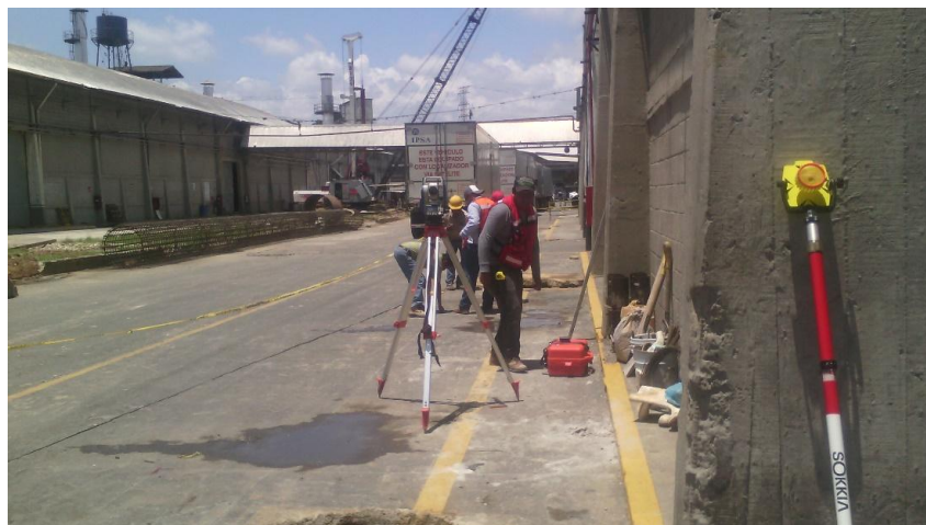
Figura 3.1.1 Proceso de niveles de topografía.
