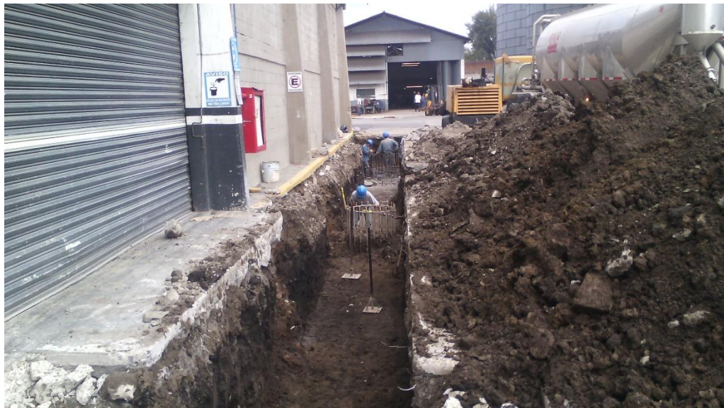
Figura 3.1.3. Construcción de pilas y dados.
