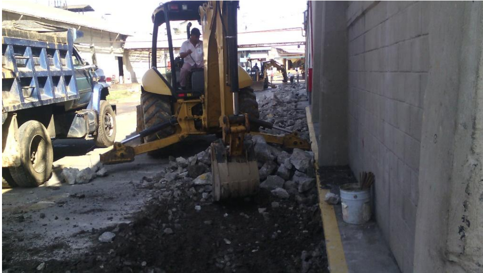
Figura 3.1.2. Iniciación de excavación.
