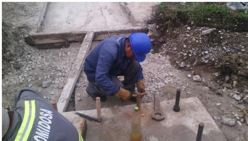
Figura 3.1.5 Supervisión de anclajes.
