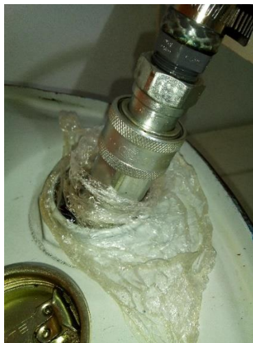
Fig. 39.- Colocación de Válvula antirretorno.
