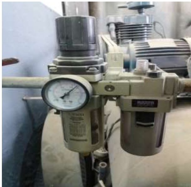
Fig. Filtro de aceite para aire (fuente: KENWORTH DEL ESTE S.A. DE C.V.)
