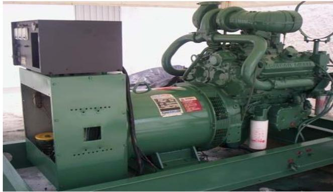
Imagen 3.22 motor de generación eléctrica
