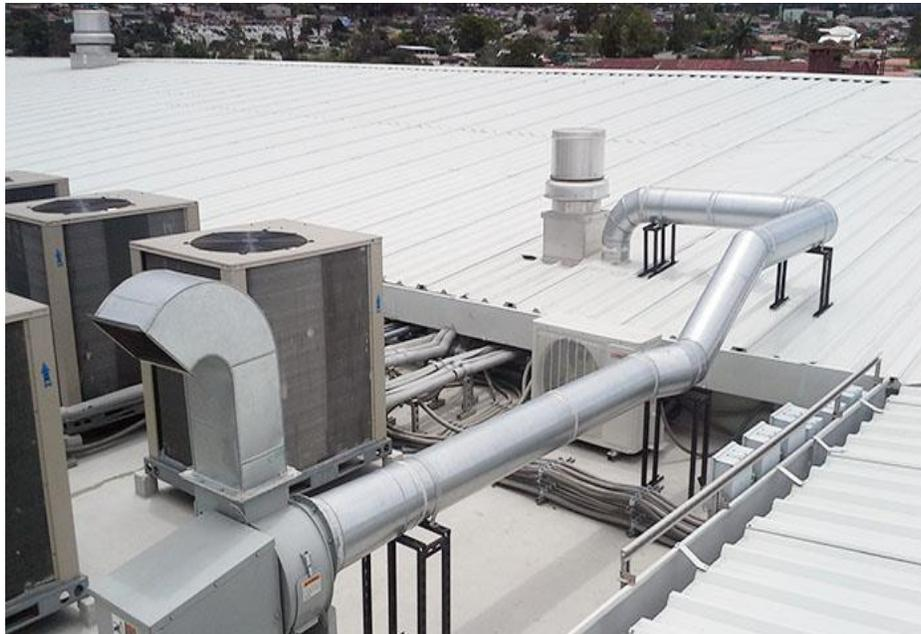
Paso 4. Después de que se conectó y se centró el ducto general se hace una ramificación con reducción
