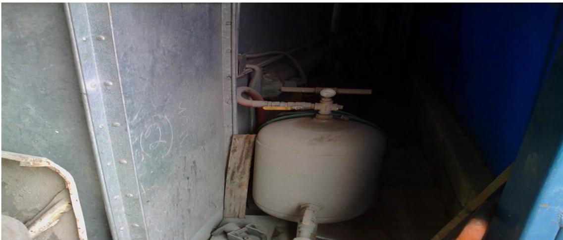
Las canalizaciones de aire comprimido, los filtros y los elementos de corte y regulación tienen la misión de que el aire llegue en las mejores condiciones a la aplicación final de la pintura. Eliminarán los aceites del circuito y el agua, producto de la condensación, así como las partículas de suciedad de las propias tuberías, todas ellas constantemente presentes en el aire presurizado. Para garantizar un
