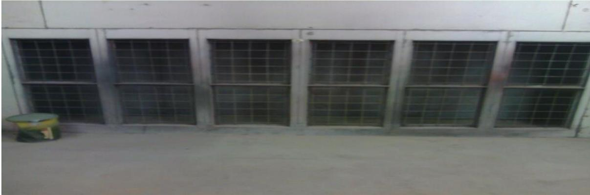
La manta "VA" se provee cortada a medida. Filtro De Piso - Lateral O pared Laberíntico (Retenedor De Pintura). Es un filtro de cartón perforado dispuesto en forma laberíntica con una gran capacidad de retención de pintura y barnices húmedos. Retiene hasta 16 kg/m<sup>2</sup> de pintura seca.
