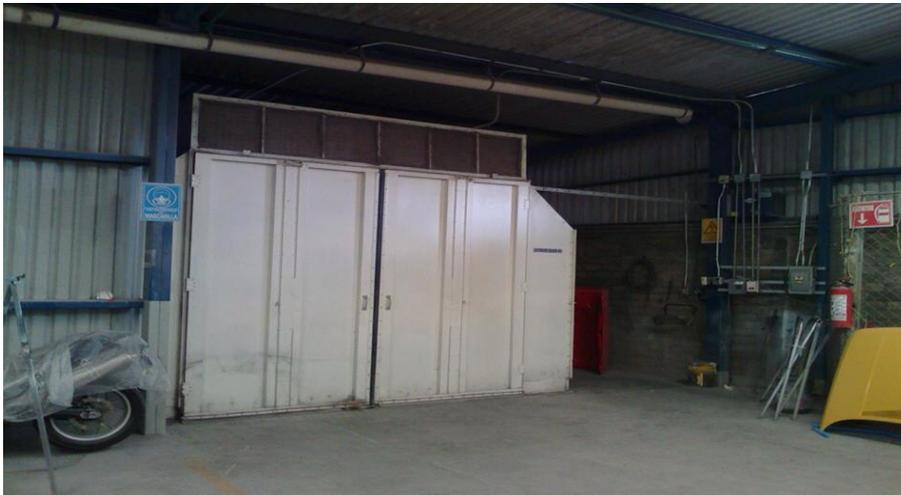
Una de las instalaciones que exige un mantenimiento más exquisito es la cabina de pintura: limpieza de sus paredes y de las rejillas del piso, perfecto estado del foso, recubrimiento de las lámparas, de las gomas de puerta y de las turbinas de extracción y del quemador de caldera...
