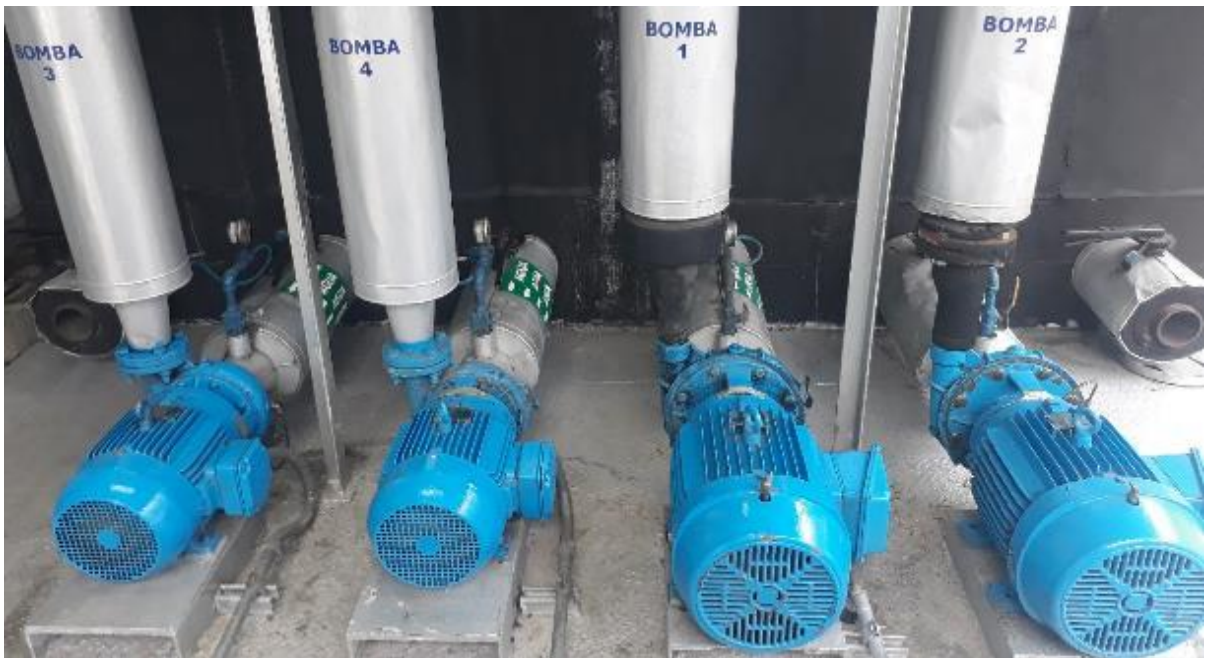
Ilustración 5 Bombas centrífugas
