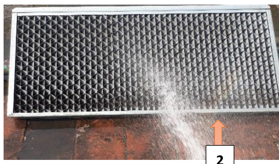
Ilustración 57 Limpieza de paneles
