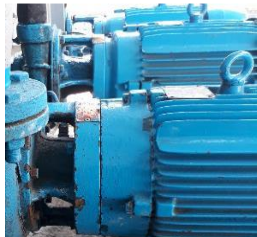
Ilustración 24 bombas centrifugas
