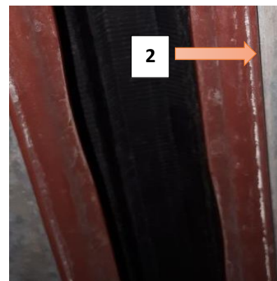
Ilustración 71 Guía desgastada
