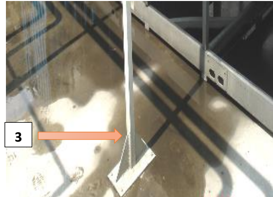
Ilustración 32 área limpia chiller
