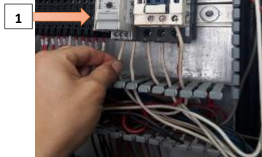
Ilustración 10 contactores
