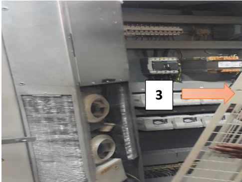
Ilustración 88 Retiro de guarda sistema de enfriamiento
