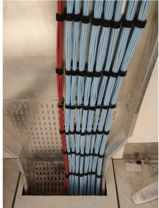
Ilustración 3 Cableado peinado
