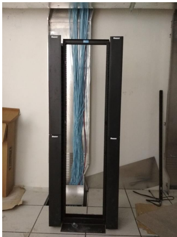
Ilustración 10 Armado de Rack
