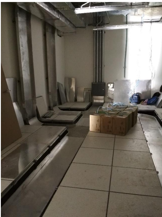
Ilustración 9 Inicio de cableado en SITE
