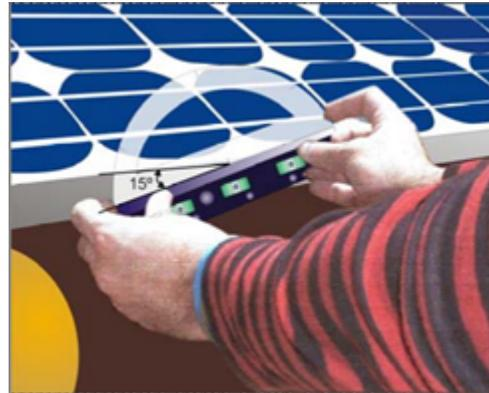
Existen estructuras y/o soportes de los módulos de un solo cuerpo, fabricados con el ángulo de inclinación recomendado.
