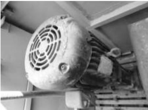
Fig. 1 Motor de 20 hp del sistema de bombeo de agua
