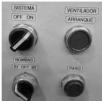
Fig. 6 Identificación y posición de los botones del tablero
