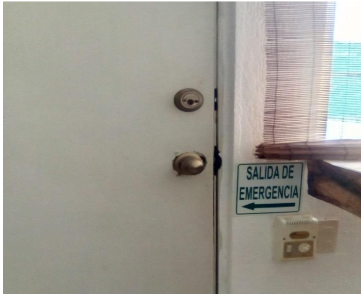
Figura 10 Señalización de salida de emergencia
