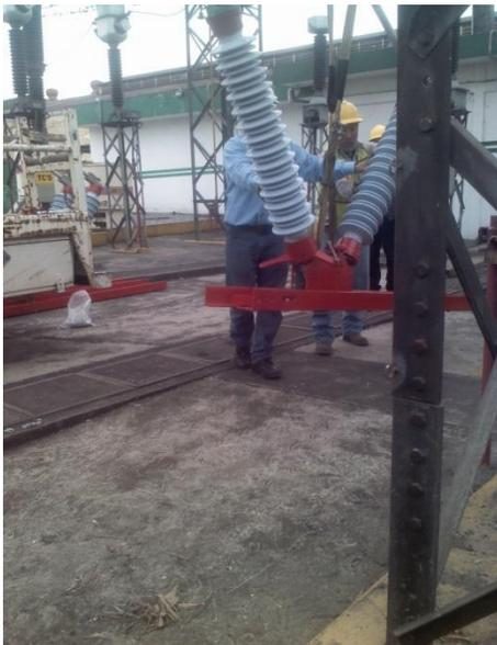
Imagen 3.25 O.T. Inicio de instalación de seccionadores ED-97V1M verticales.
