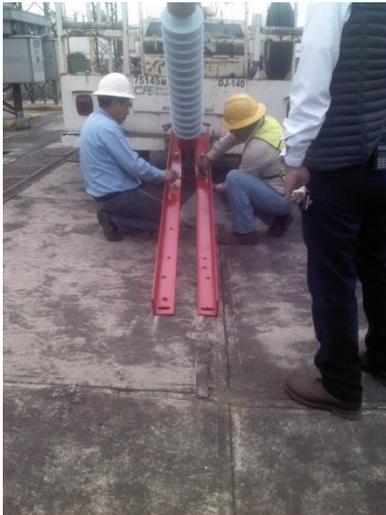
Imagen 3.23 O.T. de instalación de seccionadores ED-97V1M verticales.
