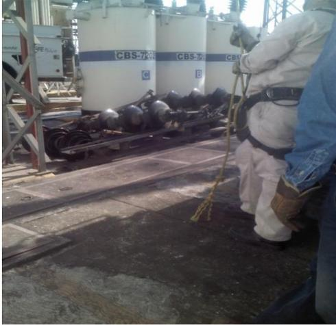
Imagen 3.24 O.T. Desinstalación de seccionadores ED-97V1M verticales.
