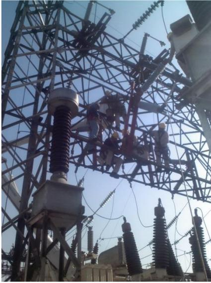
Imagen 3.26 Instalación de seccionador ED-97V1M vertical.
