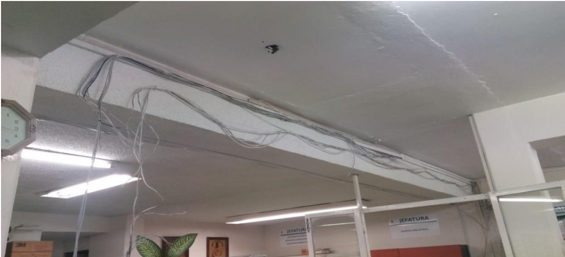
Figura 6 Retiro de Cableado
