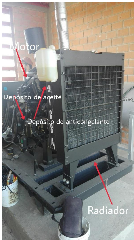
Ilustración 14 Partes de Planta de Emergencia
